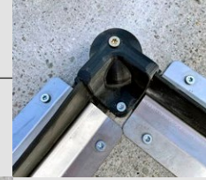
Köşe bağlantısı montaj
